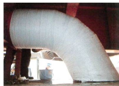
大口径(φ600)の水管橋エルボ部の補修・補強現場
