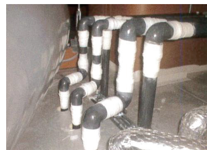
工場の新設薬品配管へ、継手部漏れ予防の為の補強現場
