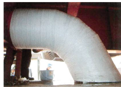
大口径(φ600)の水管橋エルボ部の 補修・補強現場
