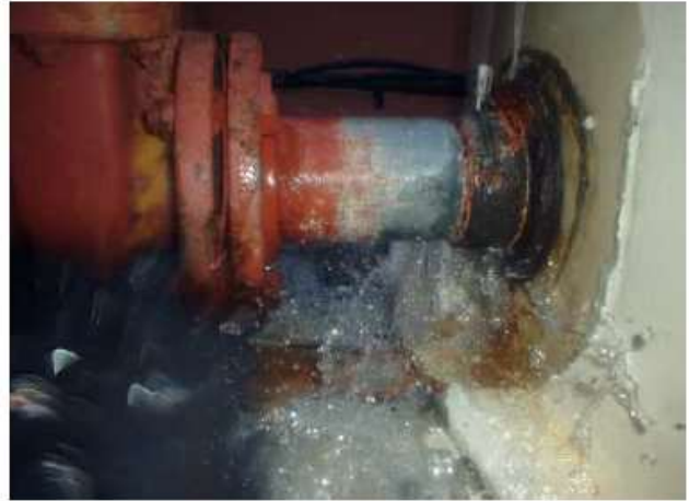
②補修金具を外すと水が噴き出す。傷口は親指程の穴が開いている。
