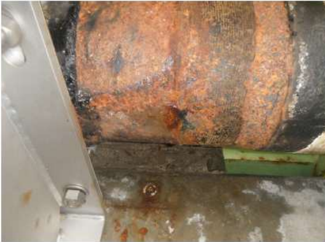
①漏水箇所の確認をする。
