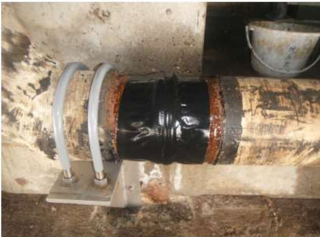
③周辺も、管肌が露出している部分は、防食の為 プチルロールで覆う。
