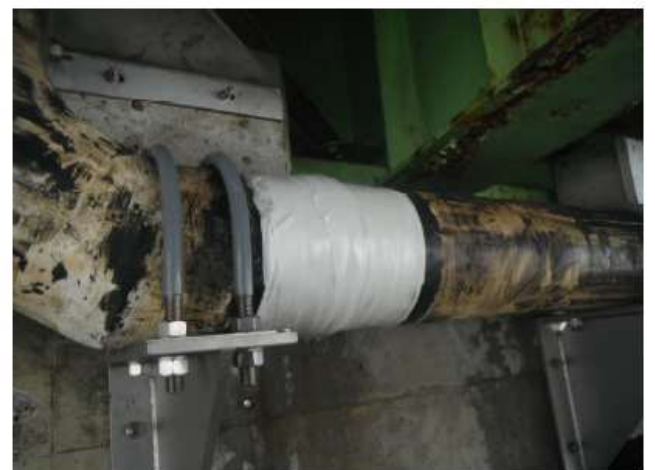
⑥漏水箇所の補修処理、腐食部も、最後に防食補強を 兼ね備えたマホータイを巻き付け補強する。
