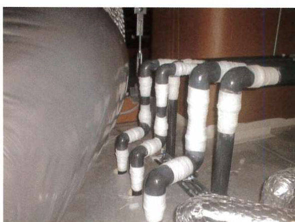
⑥配管継手部補強完了。
