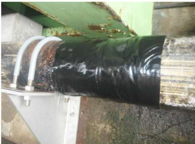
⑤オリシールを塗布後、プチルロールで露出部分を覆い、 下地処理を行う。
