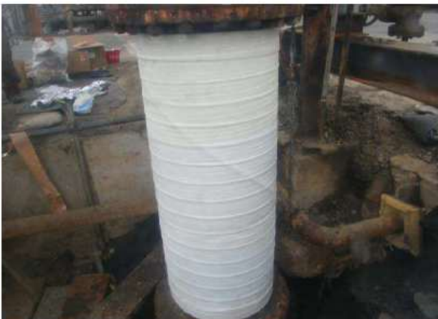
⑤1.5m全てを巻き、1本目の施工完了。
