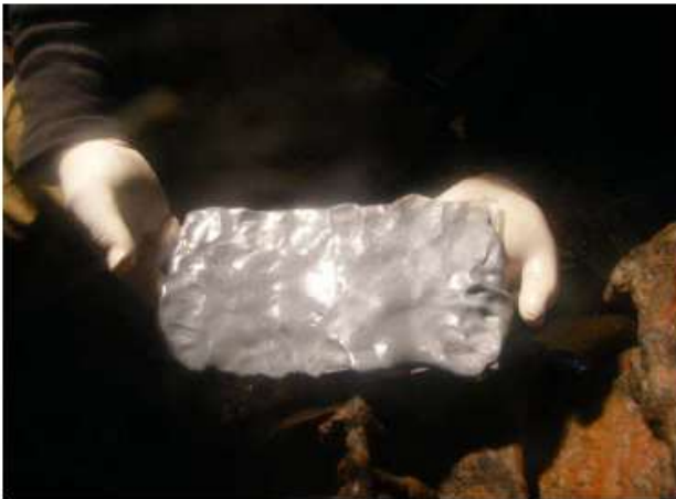
③次に、今回は穴が大きい事から、ステンメッシュを穴を塞げる大きさに切り、まず半面にオリスチールを貼りつける。
