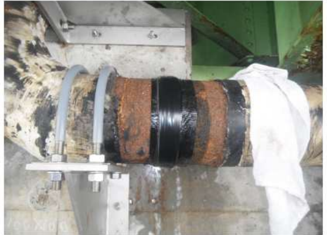
②下地にプチルロールを当て、 オリステーブで止水作業を行う。
