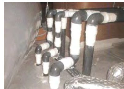
工場の新設薬品配管へ、継手部漏れ予防の為の補強現場
