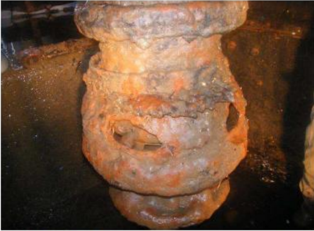
①現場の状況を確認する。 約10cm四方と約15cm四方の穴を2箇所確認する。
