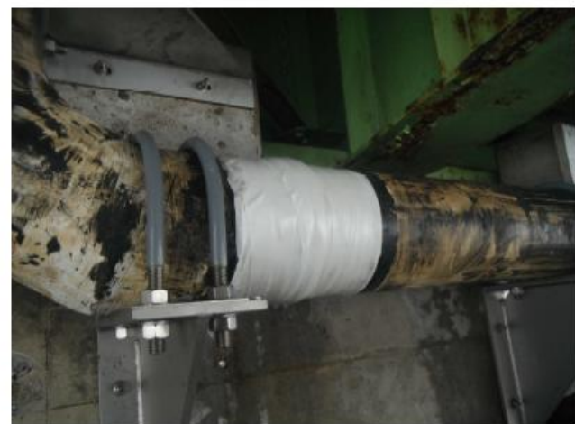
⑥漏水箇所の補修処理、腐食部も、最後に防食補強を 兼ね備えたマホータイを巻き付け補強する。
