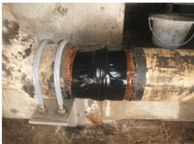
③周辺も、管肌が露出している部分は、防食の為 ブチルロールで覆う。
