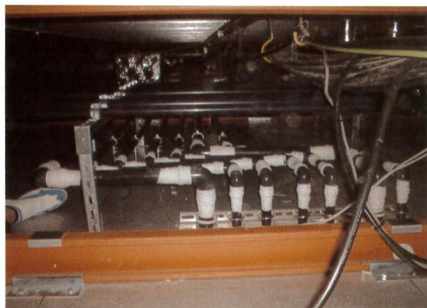
⑤マホータイを巻いた方向と同じ方向によく絞り、補強完了。
