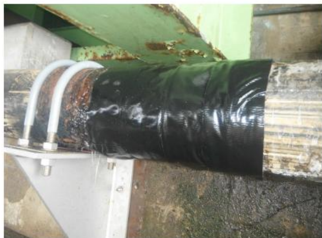
⑤オリシールを塗布後、ブチルロールで露出部分を覆い、 下地処理を行う。
