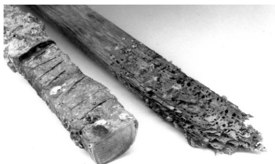
テスト木柱の切断面比較: マホータイを巻いた左側木柱は新品のまま
