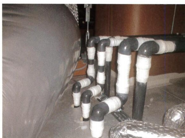
⑥配管継手部補強完了。
