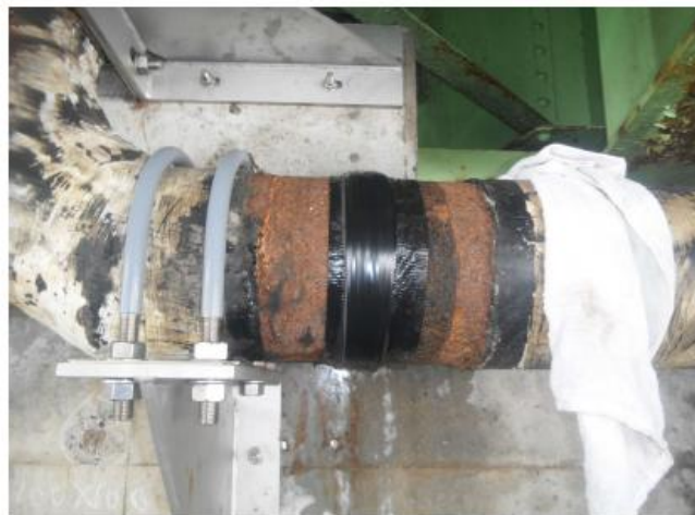
②下地にブチルロールを当て、 オリステープで止水作業を行う。
