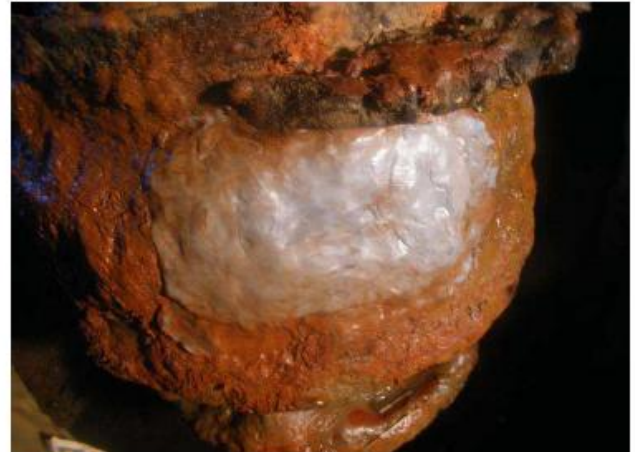
④続けて、傷口に当てがいながら、もう半面にもオリスチールで挟み込むように貼り付け、傷口を完全に覆う。 (もう1箇所も同様に施工する。)
