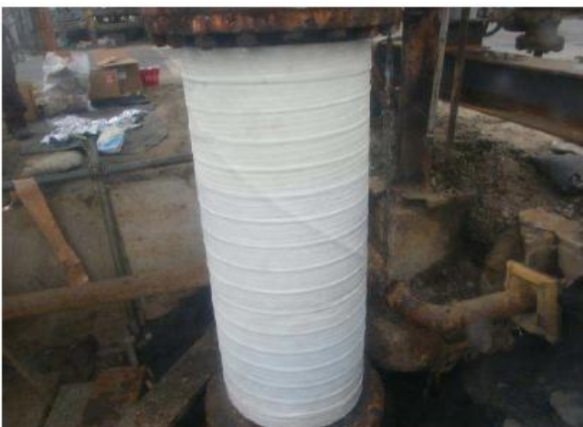
⑤1.5m全てを巻き、1本目の施工完了。
