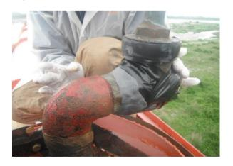
⑤仮止水後、継ぎ目のネジ部、段差部分にオリスチール(金属粉入固形エポキシパテ)を補強を兼ねて、マホータイを巻き易い様に充填する。
