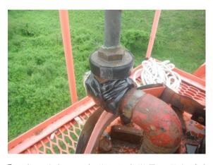
④上部の合わせ目部分からも微量の漏水が確認出来た為、③と同様に施工を行う。(こちらは一点集中で巻く。)
