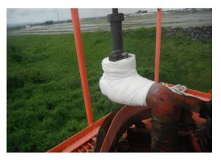
⑥最後に、防食補強を兼ね備えたマホータイを全体に巻きつける。巻き終わり後、硬化剤の水を含ませ巻いた方向と同じ方向に絞り、作業終了。(止水はオリステープの段階で出来ている為、マホータイの硬化時間を待たず完了可能。)
