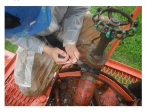
②最初に、下地としてブチルロール(下地用ブチルゴム)を当て、その上からオリステープ (仮止め用止水テープ)で止水作業を行う。
