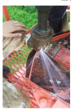
①漏水箇所の確認 以前に補修したテープ等を全て除去して頂く。傷が広がっており20mm程の亀裂が入り噴出している。
