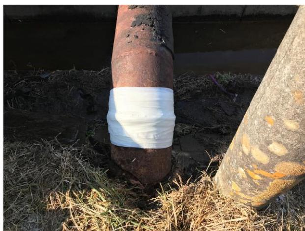
④最後に、防食・補強を兼ね備えた延命補強材マホータイ(特殊レジン含浸グラスファイバーテープ)に水を含ませてから巻く。巻き終わり後、水と反応して出る樹脂を全体に行き渡らせる様に巻いた方向と同じ方向へ撫で付け、緩みを無くすように絞り施工終了。
