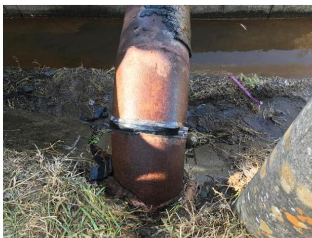
③次にブチルロール(下地用ブチルゴム)を傷口が隠れる大きさに切り、傷口に押し当てる。その上からオリステープ(仮止め用テープ)を傷口の真上に一点集中で強く引っ張りながら巻き仮止水を確認する。
