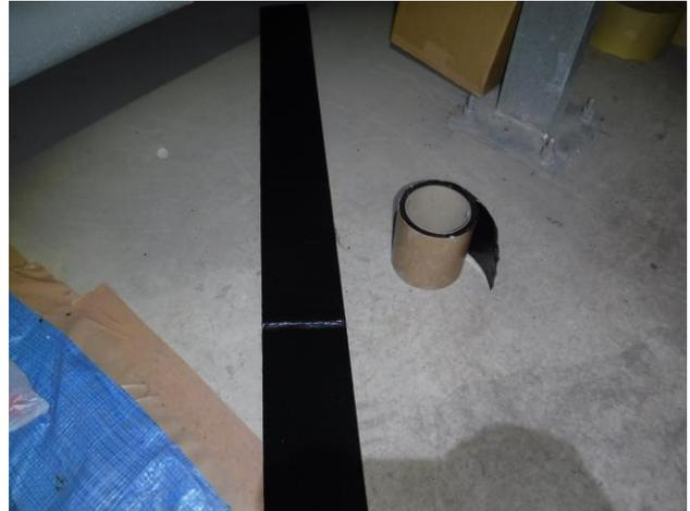
②配管と天井の幅が狭いため、ロールの状態では巻いていけないので、ブチルロール(下地用ブチルゴム)を1枚ずつ切り分ける。
