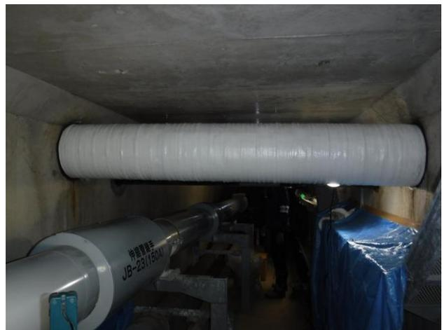
④最後に、保護・補強を兼ね備えたマホータイ(特殊レジン含浸グラスファイバーテープ)に硬化剤の水を含ませてから巻く。巻き終わり後は、巻いた方向と同じ方向へ撫で付け、緩みを無くすように絞り施工終了。
