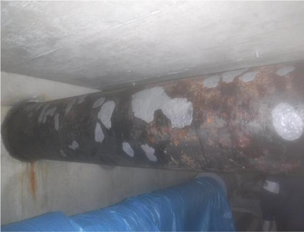
①施工箇所の確認をさせて頂く。まず、腐食の激しい箇所をオリスチール(金属粉入エポキシパテ)を充填する。
