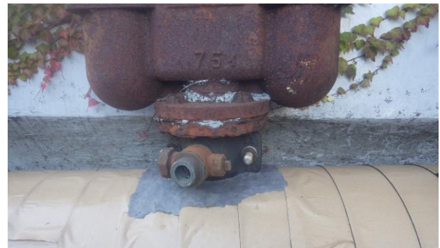
④錆の凹凸を埋める目的で全体にブチルロール(下地用ブチルゴム)を貼り付ける。
