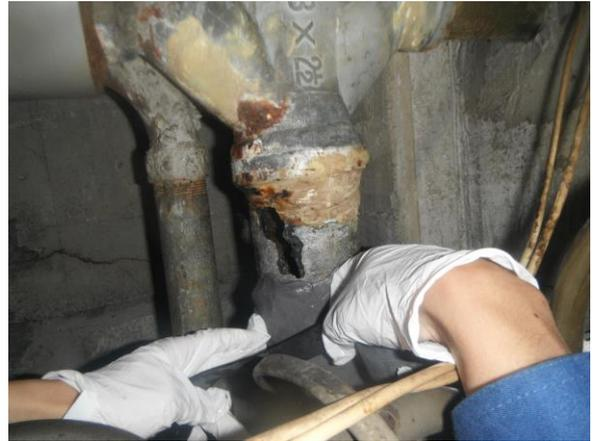
②まず下の穴を覆える大きさに切ったステンメッシュ(大きい傷穴用補修部品)の両面にオリスチール(金属粉入りエポキシパテ)を付け、傷穴を覆う様に貼る。
