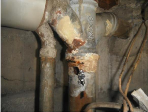
①最初に巻かれていたテープを外し、管の状態を確認する。継手下側の配管に二つの穴を確認する。
