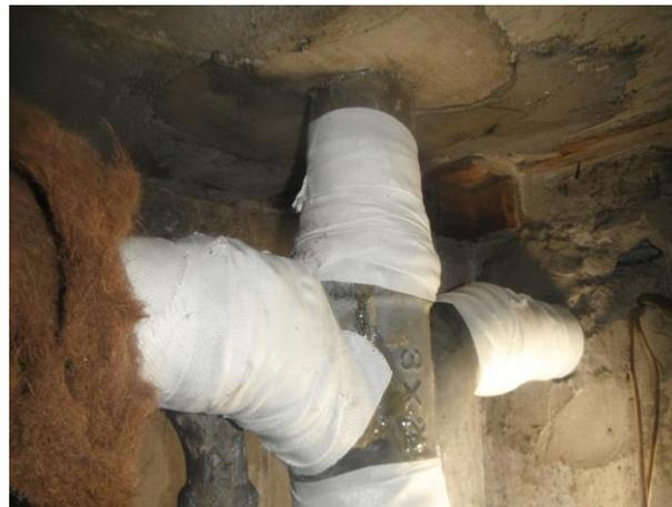
⑧最後に、防食・補強を兼ね備えた延命補強材マホータイ(特殊レジン含浸グラスファイバーテープ)を巻く。巻き終わりに、巻いた方向と同じ方向へ撫で付け、よく絞る。
