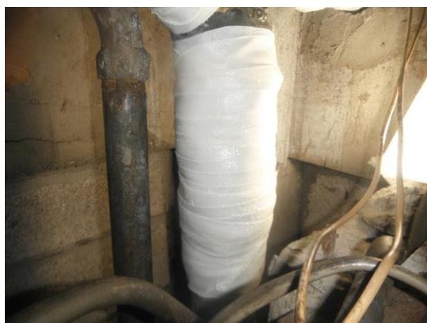
⑨穴部を仮止めした箇所も同様に防食・補強を兼ね備えた延命補強材マホータイを巻く。
