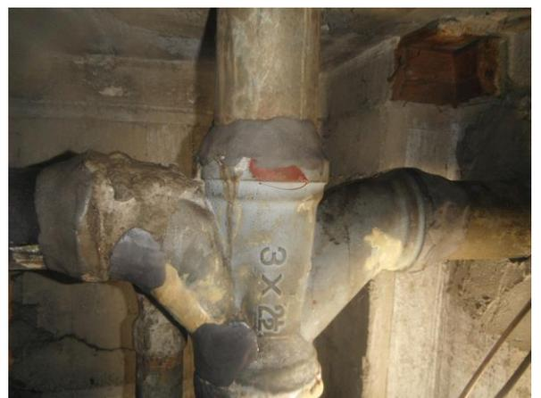
⑥続けて、継手部の補強の為、段差を埋める様にオリスチールを充填する、また、腐食している部分にも補強の為に同様に施工を行う。
