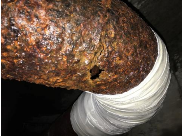
⑥拳サイズの傷の補修後、指が入る程度の傷穴の補修に取り掛かる。
