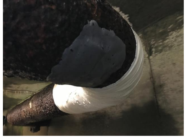
⑦まず傷穴とその周辺に補修と補強の目的オリスチールを充填する。
