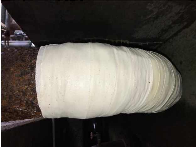
⑧最後に防食・補強を兼ね備えたマホータイを巻き、巻いた方向と同じ方向によく絞り施工完了。
