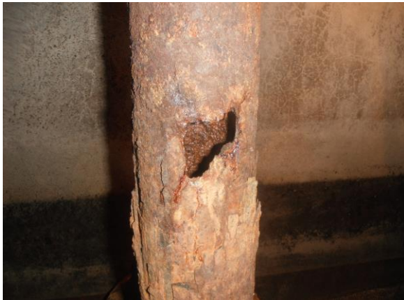
①施工箇所（1）状況確認後、ブラシ等で可能な限りケレン作業を行う。
