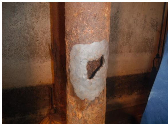
③施工箇所（1）から作業を開始。まずオリスチール（金属粉入エポキシパテ）で錆、凹み部分を補強する。
