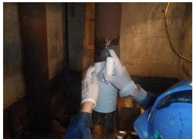
⑥下地処理後、最後に防食・補強を兼ね備えた延命補強材マホータイ（特殊レジン含浸グラスファイバーテープ）を巻いていく。
