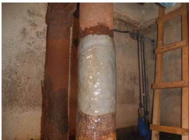
⑤更に、細かな隙間を埋め、防錆効果を高める為、オリシール（2液混合エポキシレジン）を全体に塗布する。
