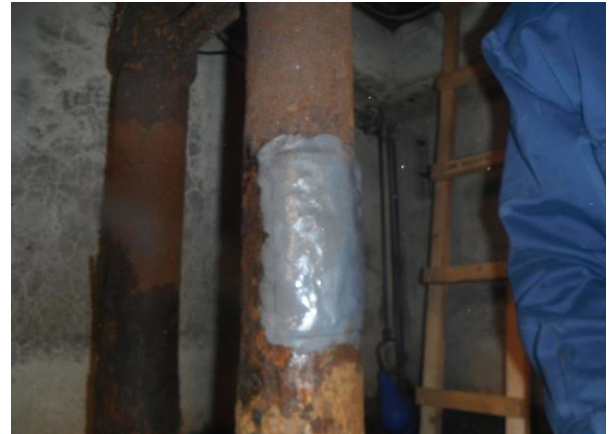
④次に、両面にオリスチールを充填したステンメッシュ（大きい傷穴用補修部品）を穴の部分を完全に覆う様に貼り付ける。
