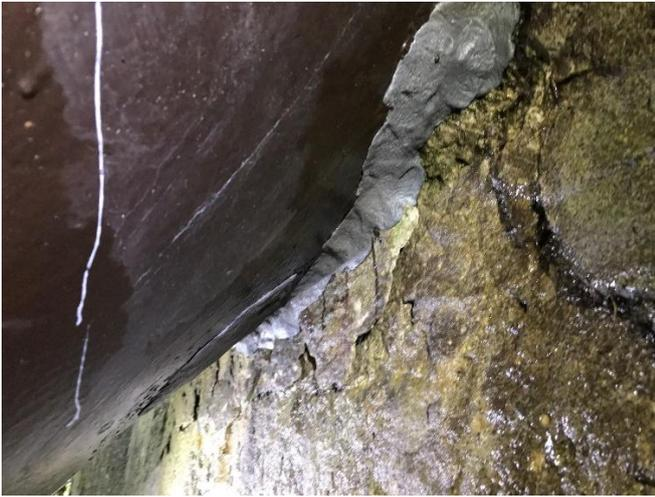
⑦架台部の際にオリスチールを充填して補強する。
