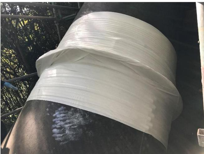
⑪フランジ部は許容範囲外であるが、マホータイがなるべく密着するように巻いていく。緩み弛みが出たら、180度ねじって締め付ける。
