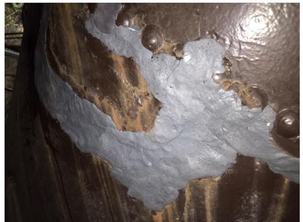
⑥腐食が酷い箇所にオリスチールを充填して補強する。
