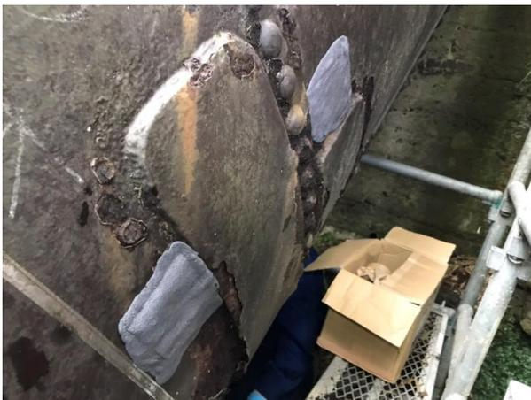
⑤ステンメッシュ（大きい傷穴用補助部品）を穴を塞げる大きさに切り、両面にオリスチール（金属粉入りエポキシパテ）を充填したシートを作成する。
