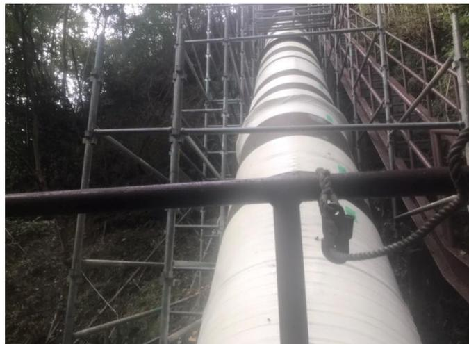
⑫巻き終わり後、硬化剤の水を含ませ、巻いた方向に撫で付けるように絞る。施工終了後、最終確認を行い、作業を完了する。
