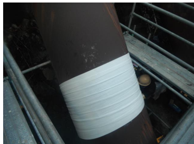
⑥施工完了 マホータイを巻き終わり後、硬化剤の水を含ませ、巻いた方向に絞り終了。
