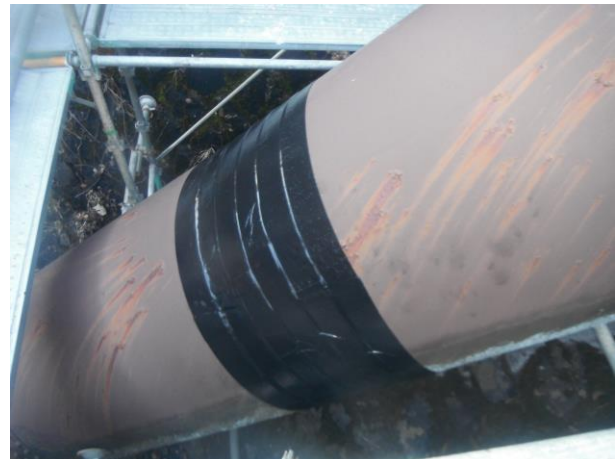
④管肌が出ないように、端の部分を1cm程重ねながら貼り合わせていく。
