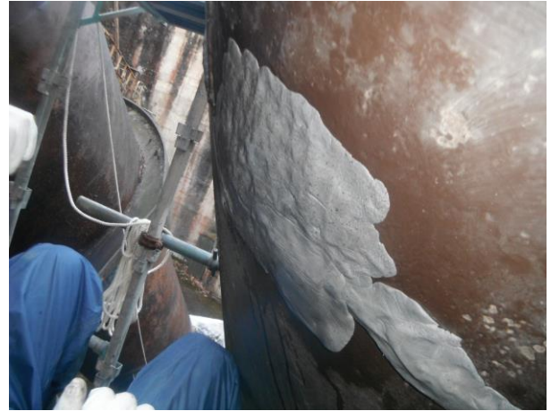
②施工開始 オリスチール(金属粉入りエポキシパテ)、並びに大きい穴用のステンメッシュ(大きい傷穴用補助部品)で穴を埋めて覆う様に充填していく。
