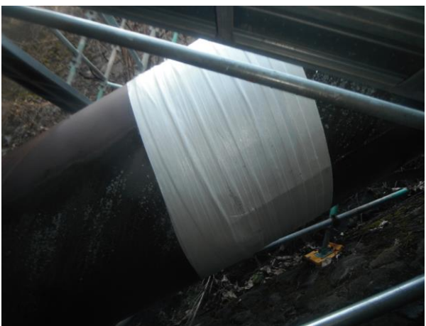
⑤最後に保護・補強の目的で、延命補強材マホータイ(特殊レジン含浸グラスファイバーテープ)を巻く。ブチルロールを完全に覆う様に、全体が4~5重となるように巻いていく。
