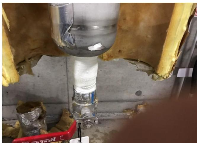
④最後に、保護・補強を兼ね備えたマホータイ(特殊レジン含浸グラスファイバーテープ)に硬化剤の水を含ませてから巻く。巻き終わり後は、水と反応して出る樹脂を全体に行き渡らせるように巻いた方向と同じ方向へ撫で付け、緩みを無くすように絞り施工終了。
