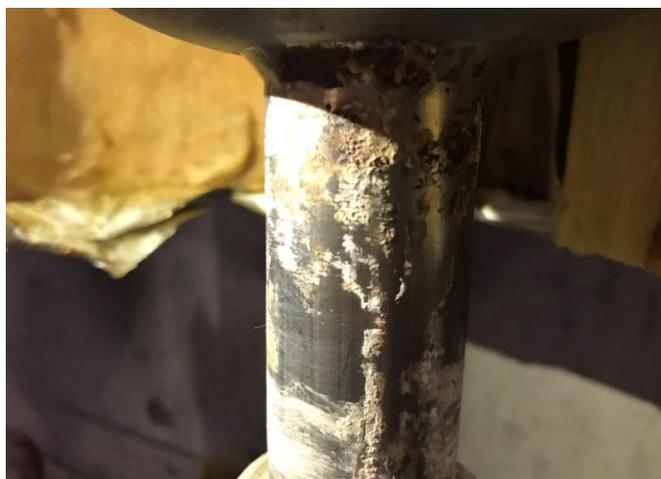
①施工箇所を確認させて頂く。表面をヘラやウェスでケレンすると傷口が確認出来る。傷口は4箇所で針穴以下の穴が並んでいる。
